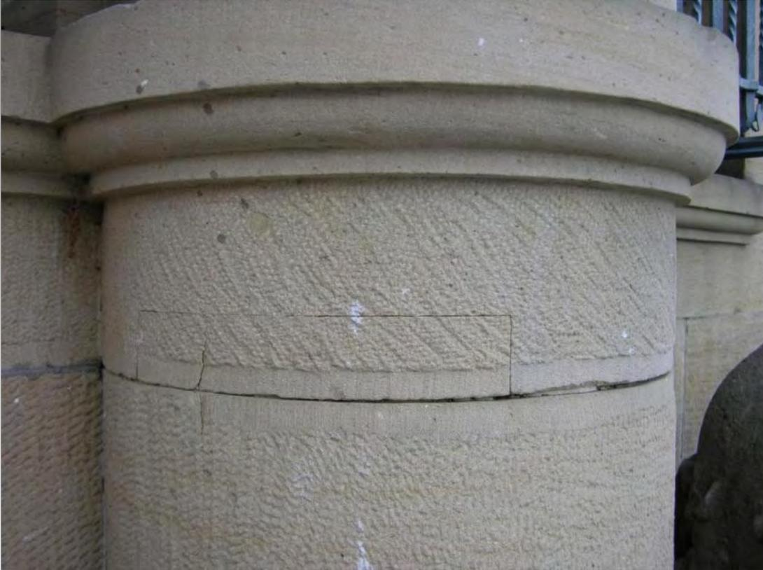
Fehlstellen werden passgenau identischem Material wiederhergestellt
