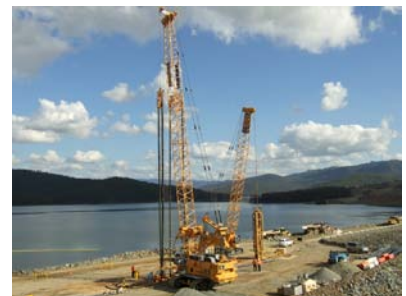
Errichtung dichtender Schlitzwände im Grundwasser Quelle: www.bauer.de
