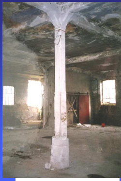
Lagerhalle in Osthofen, Baujahr 1899
