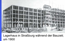
Lagerhaus in Straßburg während der Bauzeit; um 1900
